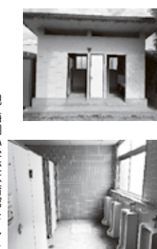
▲現梅園小学校体育館トイレ
