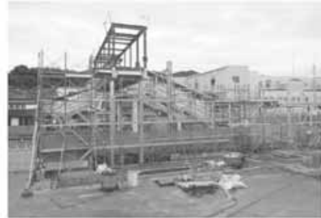
東口広場から見た 建設現場
