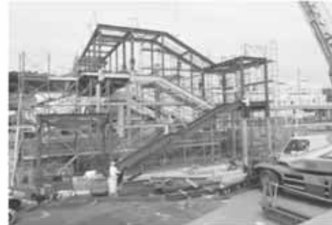
東口広場から見た 建設現場
