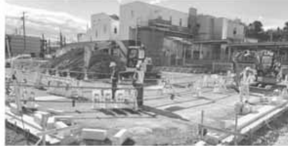
◀ 東口広場建設現場
