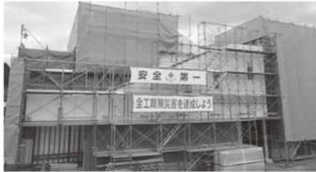
◀東口広場から見た建設現場
