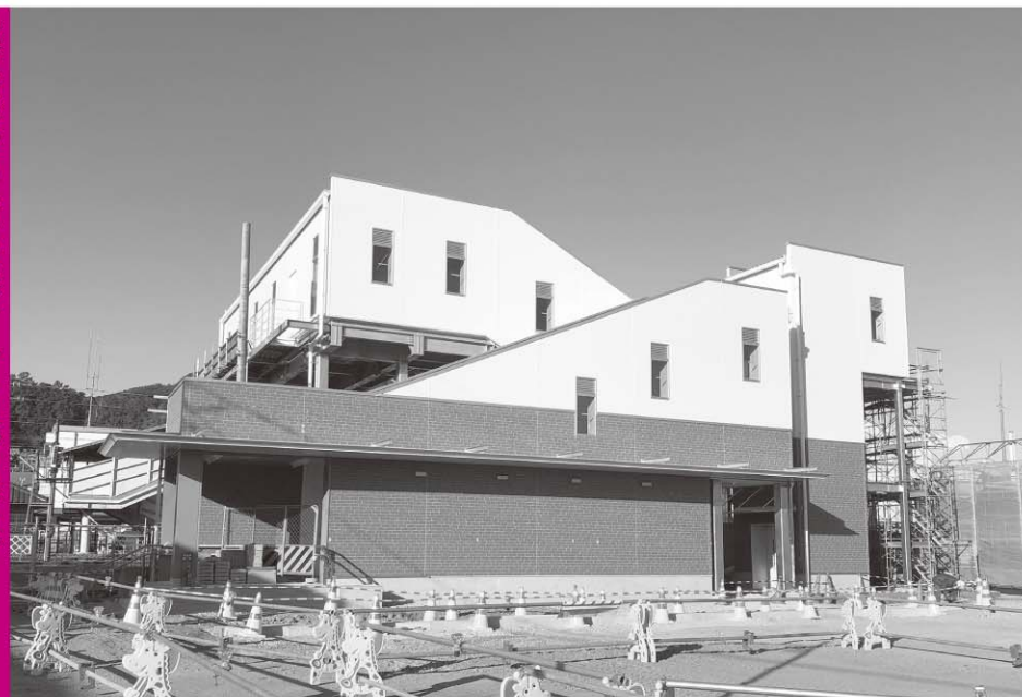
越生駅東口工事の様子（1月25日時点）
