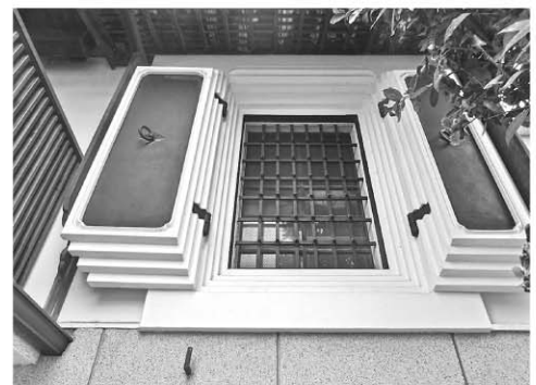
袖蔵の観音扉
