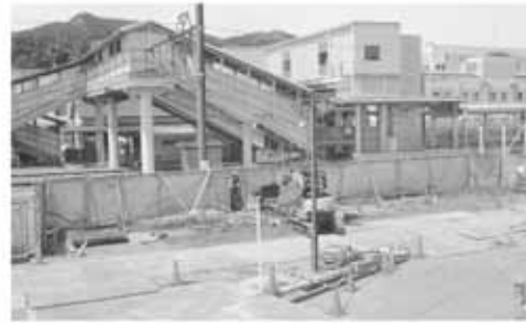
◀東口広場から見た建設現場
