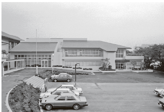
町立図書館・視聴覚ホール竣工当時 (昭和60年撮影)
