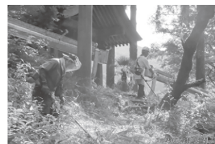
龍ヶ谷集会所付近法面の草刈り
