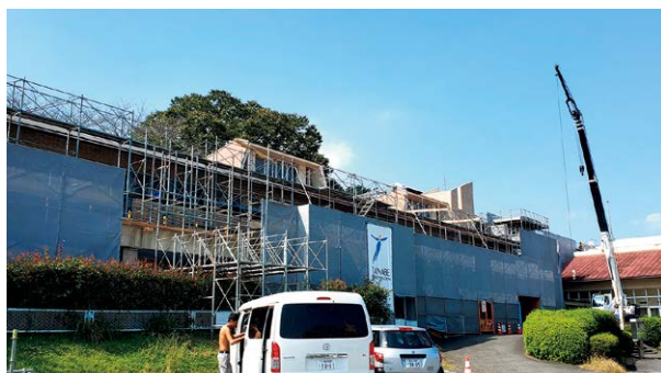
改修中の中央公民館
