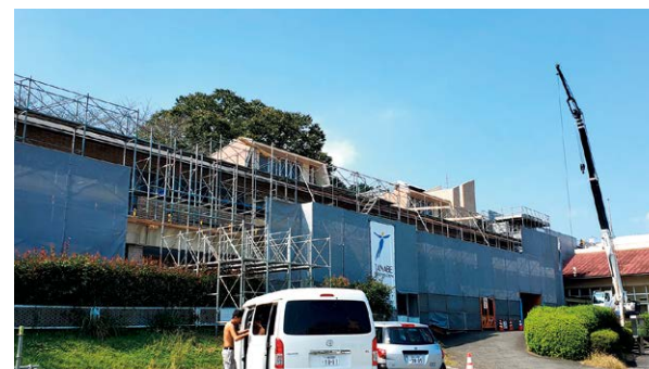
改修中の中央公民館
