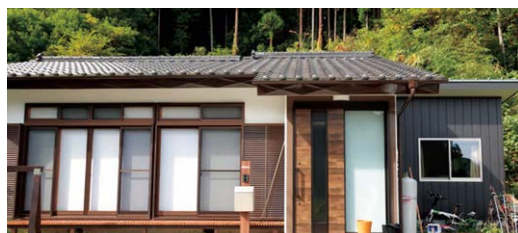
空き家バンクで購入、改修後の建物
