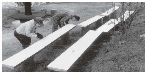
▲ベンチ・テーブル防腐剤ペンキ塗り作業の様子
