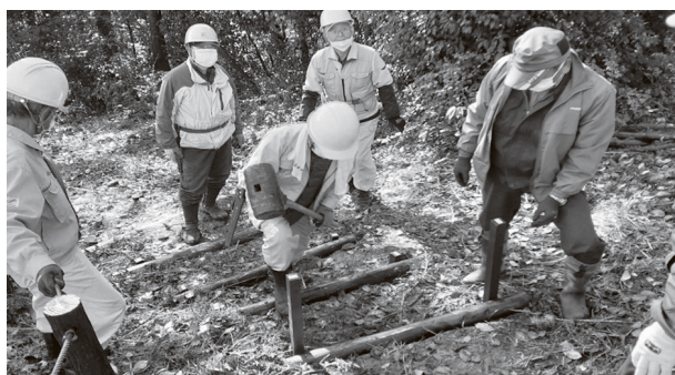
▲杭、丸太交換作業の様子
