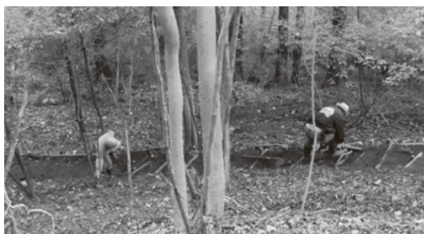
▲階段修繕作業の様子
