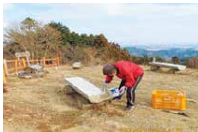
▲ベンチ塗装作業の様子
