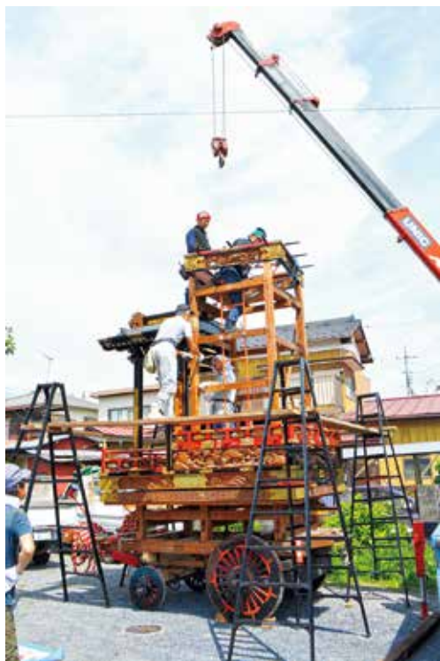
仲町山車解体作業（7月9日撮影）
