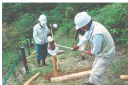
▲階段材交換の様子
