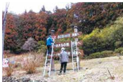
▲歓迎板の塗り替え作業の様子
