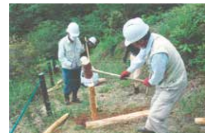
▲階段材交換の様子
