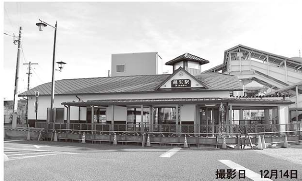
▲越生駅西口 (道灌口)
