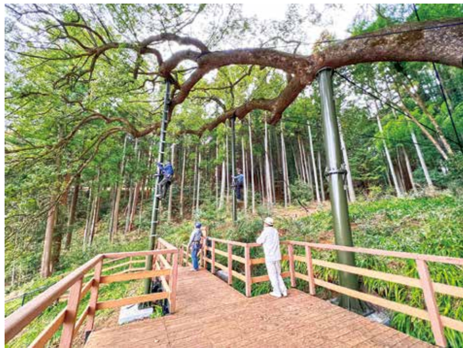
西株大枝に支柱を設置(令和3年度)
