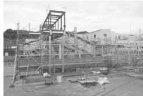
東口広場から見た 建設現場
