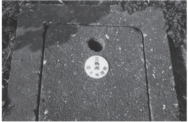
城山山頂の埋設三角点
