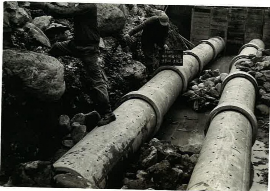
多孔管（口径800mm）施工状況（昭和40年撮影）
