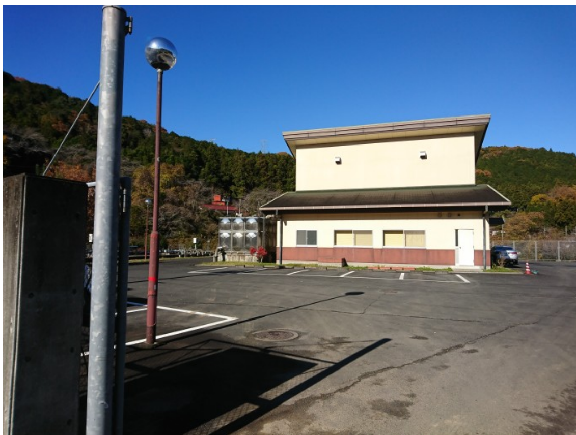
稼働から約22年が経過した膜ろ過施設
