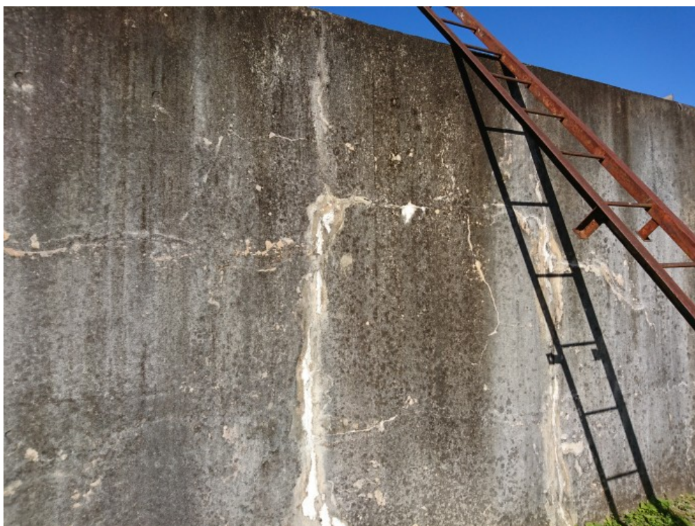
コンクリートの中性化が始まっている。
