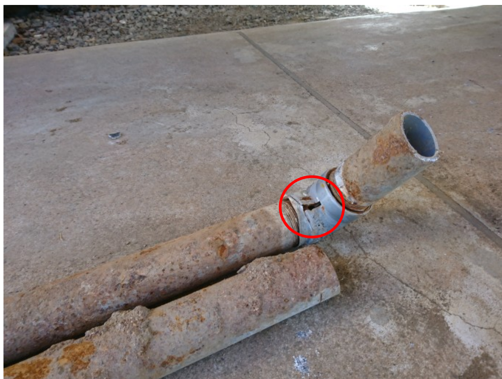
赤○部分に亀裂が確認できる。
