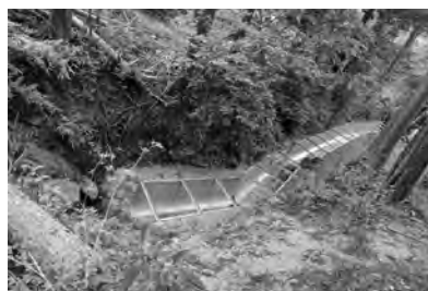
ソーラー現場・工事箇所の様子・4月19日撮影
