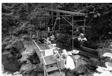
単管パイプで囲った石仏と橋に設置された注意貼紙
