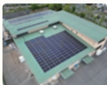
毛呂山町学校給食センターの太陽光パネル
