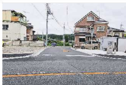
完成後の状況
