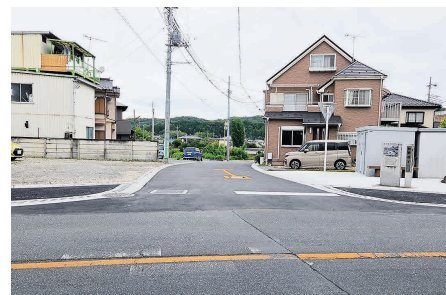
完成後の状況
