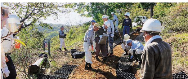
園路の改善作業の様子
