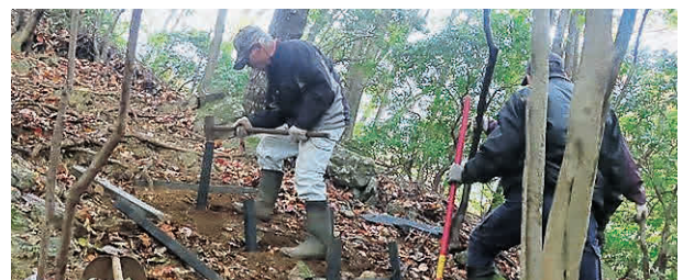
ハイキング道の階段造りの様子
