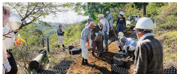
園路の改善作業の様子
