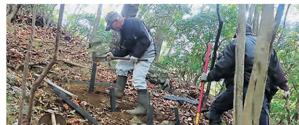
ハイキング道の階段造りの様子
