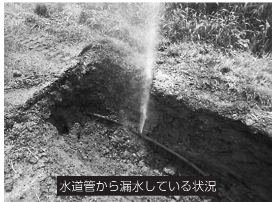
漏水調査の様子
