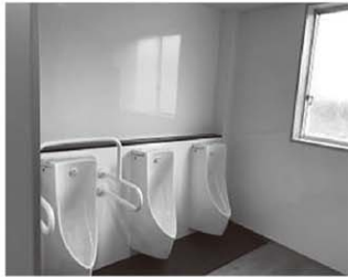
▲節水型・自動洗浄式小便器 (1F～4F男子トイレ)
