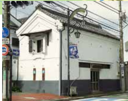
中清米店袖蔵(飯能戦争以前の建物) 飯能戦争は飯能の町も戦場になった。飯能戦争当時の建物で現存しているものはほとんどないと思われる。(飯能市本町1-1)
