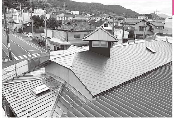
▼すてきな交流拠点上部
