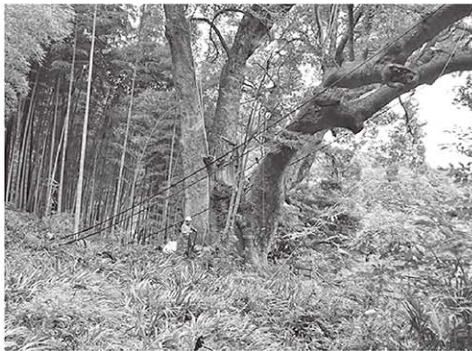
ロープによる倒伏対策工の様子 (今年10月)
