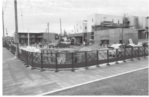
◀東口広場の建設現場
