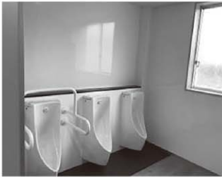
▲節水型・自動洗浄式小便器 (1F～4F男子トイレ)
