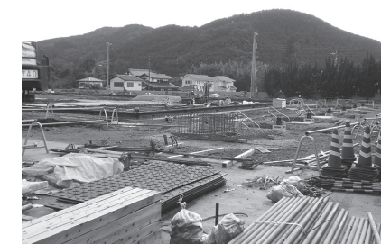
鉾山跡地現状
