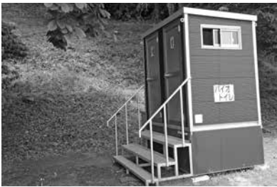
小倉城址のバイオトイレ（ときがわ町）
