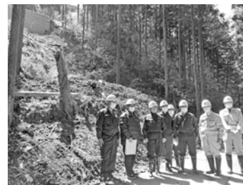
林道楠線復旧工事現場
