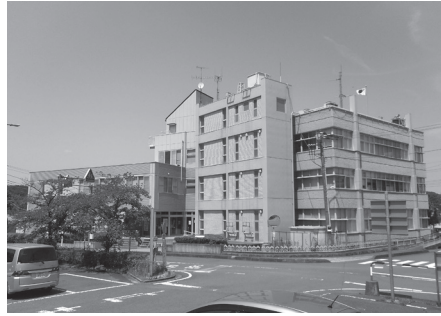
コロナ対策の司令塔・越生町役場庁舎
