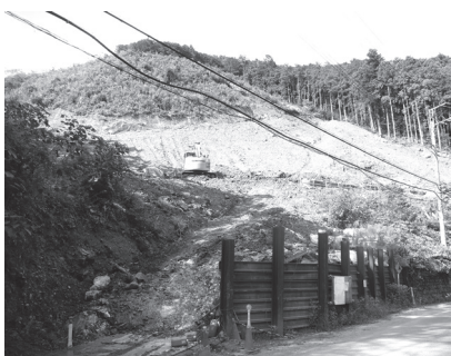
小杉メガソーラー現場
