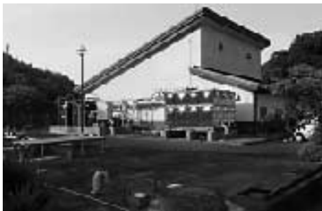
大満浄水場膜ろ過施設棟
