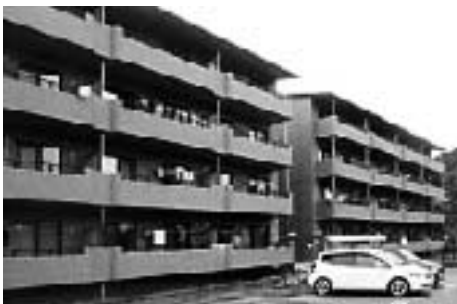
下條村の子育て世代用村営住宅
