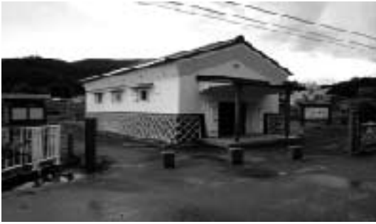
農業集落排水施設
