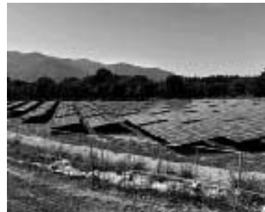
町有地の山林に建設されたメガソーラー
