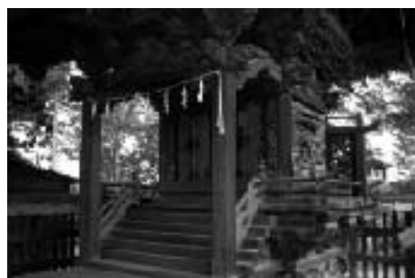
津久根の八幡神社本殿
