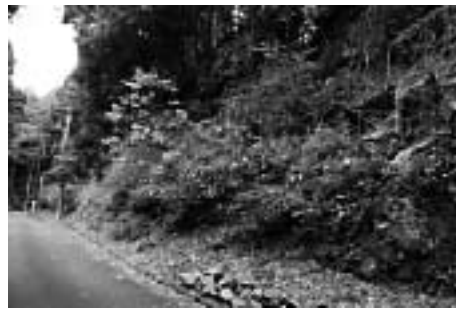
龍ヶ谷地区・のり面工事場所(補正予算)
