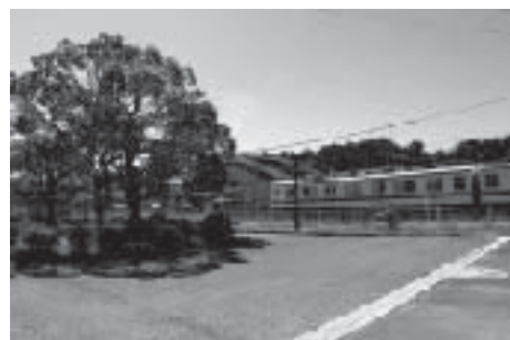
東口開設を待つロータリー
