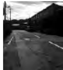
堂山地区内 町道2-13号線
