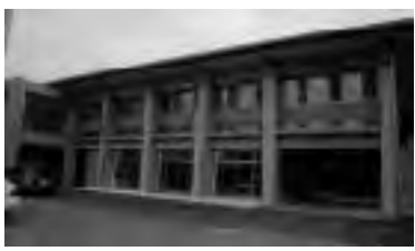
武道場建設工事事務繰越分
