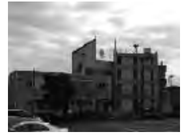
役所庁舎耐震・補強工事
