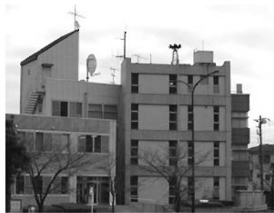
耐震補強工事が行われる庁舎
