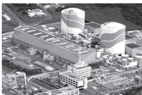
再稼働中の川内原発
