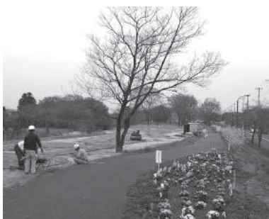
新設されるパークゴルフ場(造成中)
