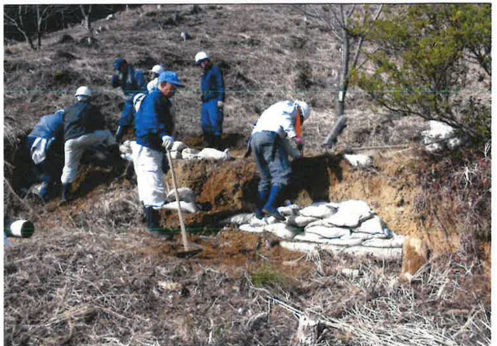
写真5 台風19号被害対応一① 園内通路端亀裂改修
