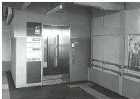
▲新設されたエレベーター
