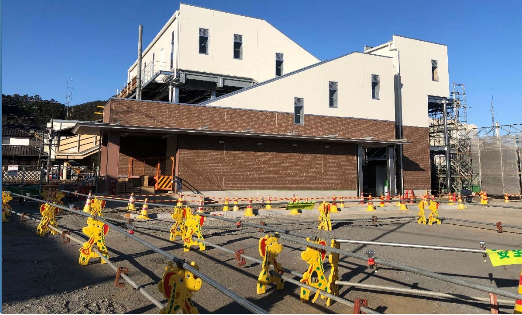
越生駅東口工事の様子(1月25日時点)
